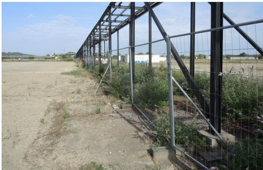
Figure 47. Vue des zones végétalisées au nord du lot CE
